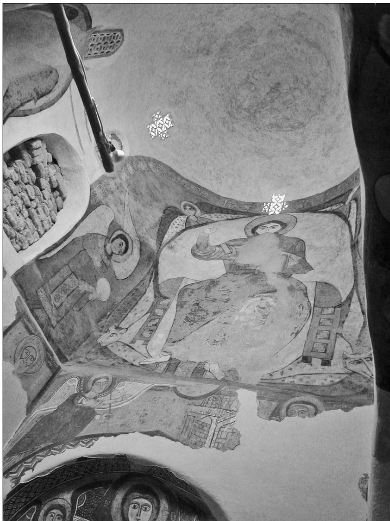
Il. 19. Cerkiew koptyjsko-prawosławny Monasteru św. Pawła Pustelnika na Pustyni Wschodniej w górach el-Qalzam w Egipcie. Kopała hieratejonu na swobodnie modelowanym oktagonalnie-cylindrycznym bębnie z quasi-pendentywami. Fot. autora
